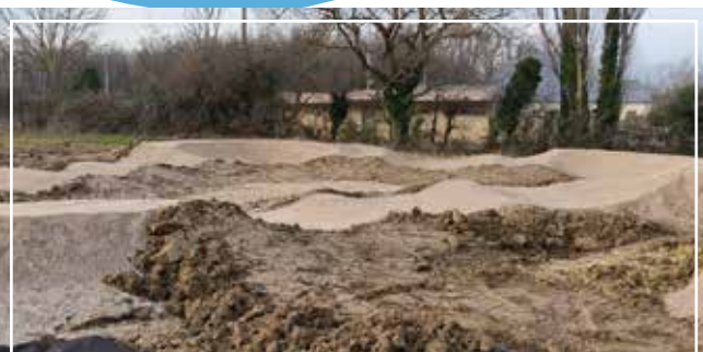
Pumptrack en phase chantier
